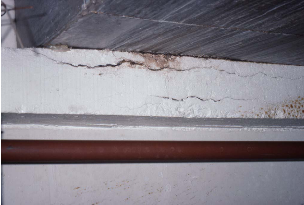
photo 1.2 : Poutre support de réservoir
