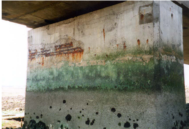
photo 1.7 : Pile en zone de marnage
