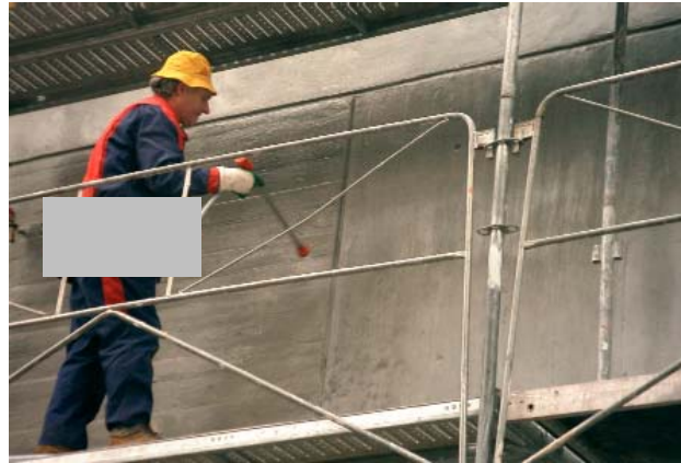
photo 4.5 : Application d'inhibiteur
