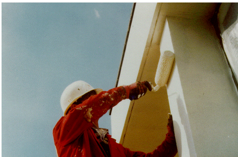
photo 4.6 : Application de la finition
