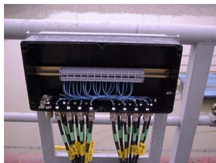
photo 4.11 : Armoire de connexions
