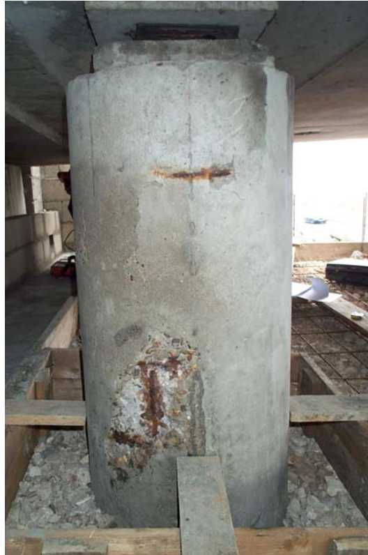
photo 1.5 : Pile de pont
