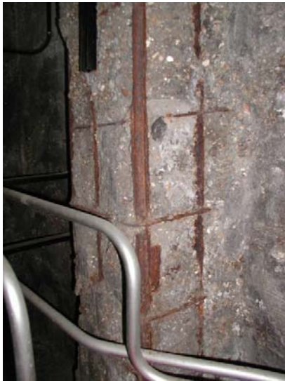
photo 1.3 : Poteau porteur sous garage
