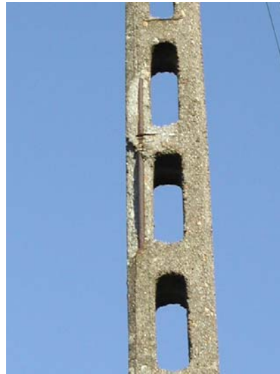
photo 1.4 : Poteau support de ligne électrifiée
