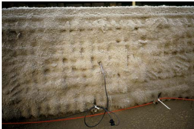
photo 4.9 : Traitement en cours
