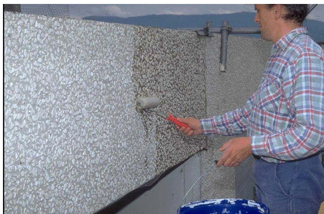
photo 4.4 : Application d'inhibiteur
