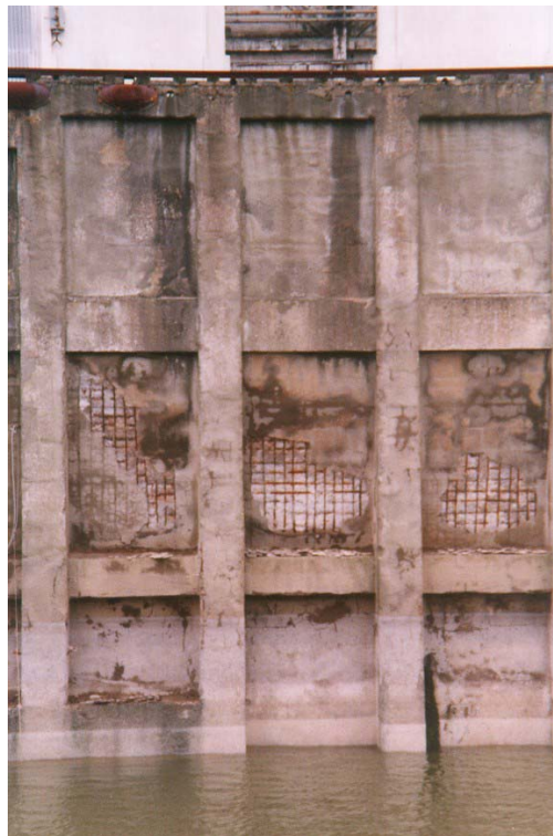
photo 1.9 : Quai en zone de marnage
