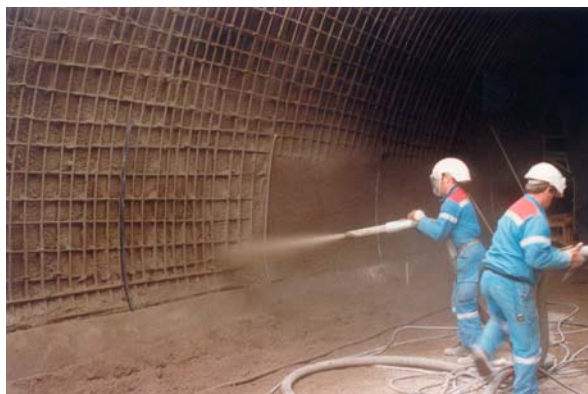
photo 4.7 : Projection de béton
