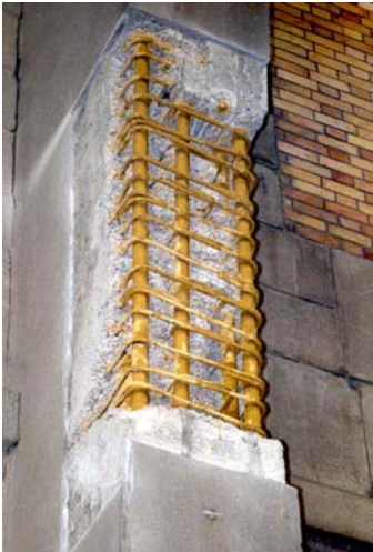
◀ photo 4.1 : Protection des armatures
