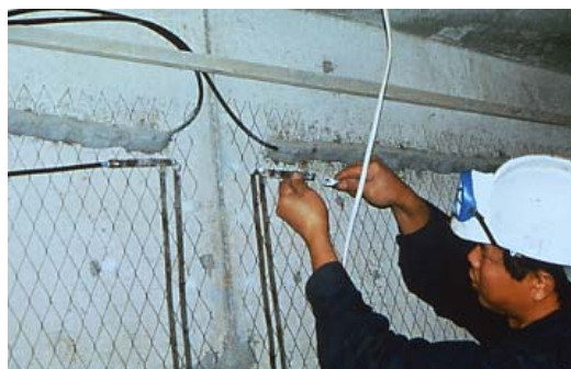
photo 4.10 : Mise en place du treillis anodique
