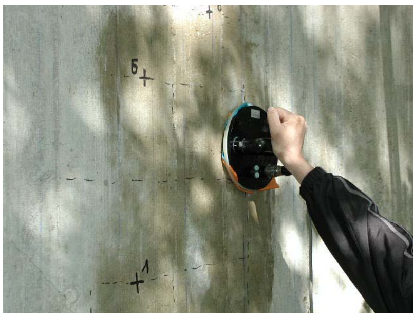
photo 2.4 : Mesure de vitesse de corrosion
