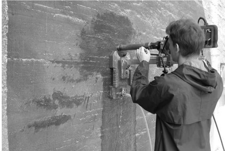
photo 2.5 : Prélèvements par carottage
