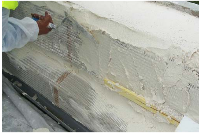
photo 4.8 : Application de la pâte sur le treillis
