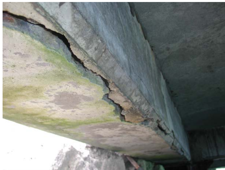
photo 1.8 : Poutre de tablier
