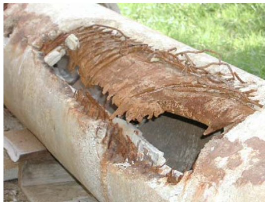
photo 1.10 : Tuyau en béton armé
