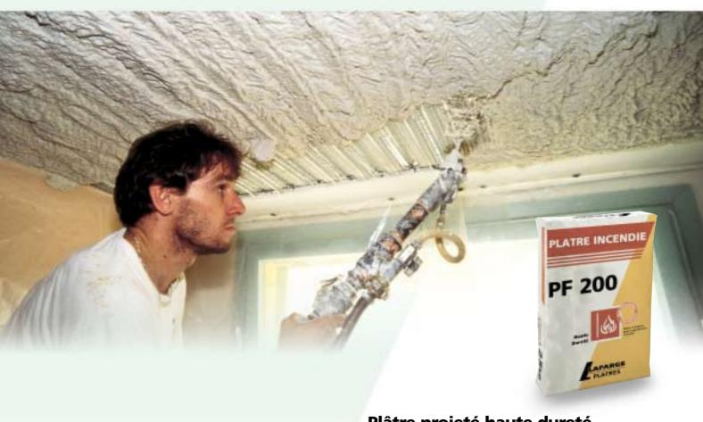
Plâtre projeté haute dureté, pour la protection passive incendie
